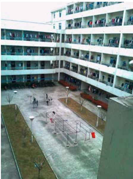
Außenansicht des ArbeiterInnenwohnheims Nr. 9 der Mingshuo-Fabrik
